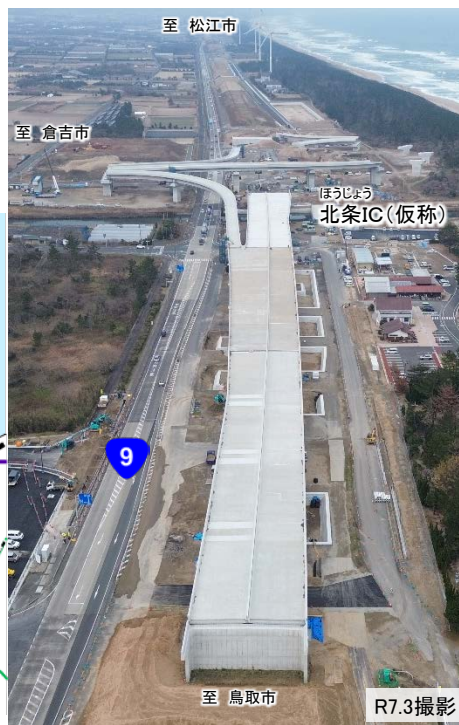
【写真①】北条高架橋（仮称）の施工状況
