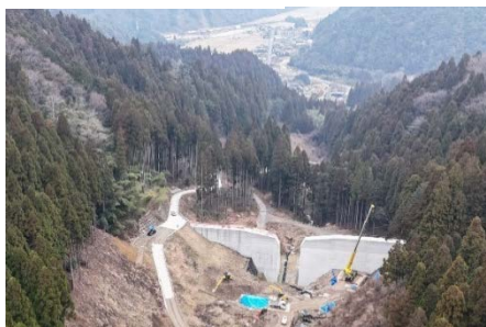
穴鴨4号砂防堰堤(R7年度完成予定)
