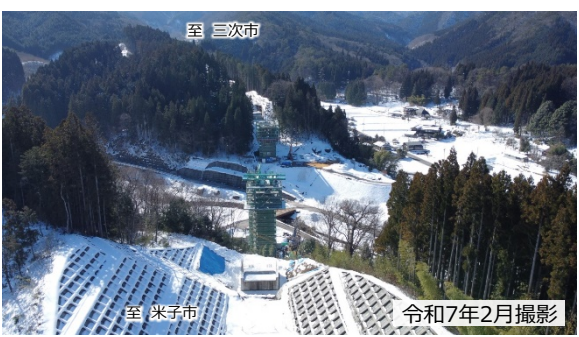
【写真①】 新屋地区の施工状況
