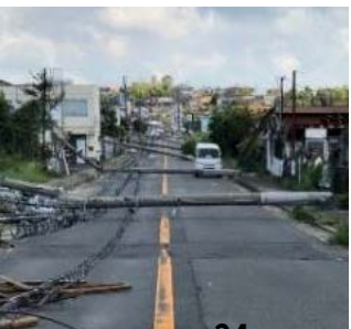
<電柱の倒壊による道路閉塞の事例>
