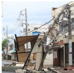
<飛来物による電柱倒壊の事例>
